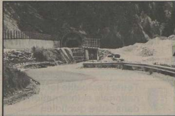
Une vue du portail nord où des travaux sont actuellement exécutés en faveur de l'aménagement de la voie d'accès.
